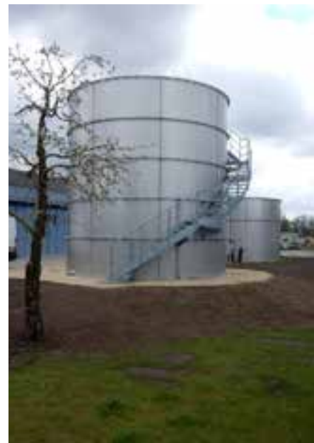
oben: Faultürme der Kläranlage Edenkoben, © Verbandsgemeinde Edenkoben
