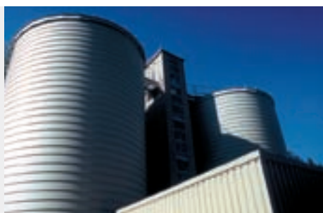
Bild 1: Zweistufige Hochleistungsanlage zur Vergärung von Klärschlamm in Leonberg.
