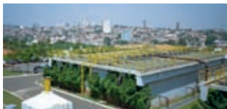
Bild 2 (unten): Aerobe Nachreinigung im belüfteten Längsbecken.
