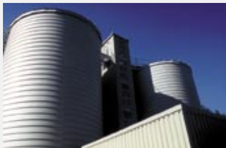
Bild 1: Zweistufige Hochleistungsanlage zur Vergärung von Klärschlamm in Leonberg.
