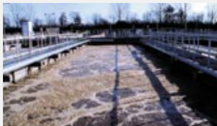
Bild 2: Belebungsbecken einer Kläranlage. Das Fraunhofer IGB optimiert und erweitert bestehende Abwasserreinigungsanlagen nach systematischer Analyse und spezifischen Messungen.
